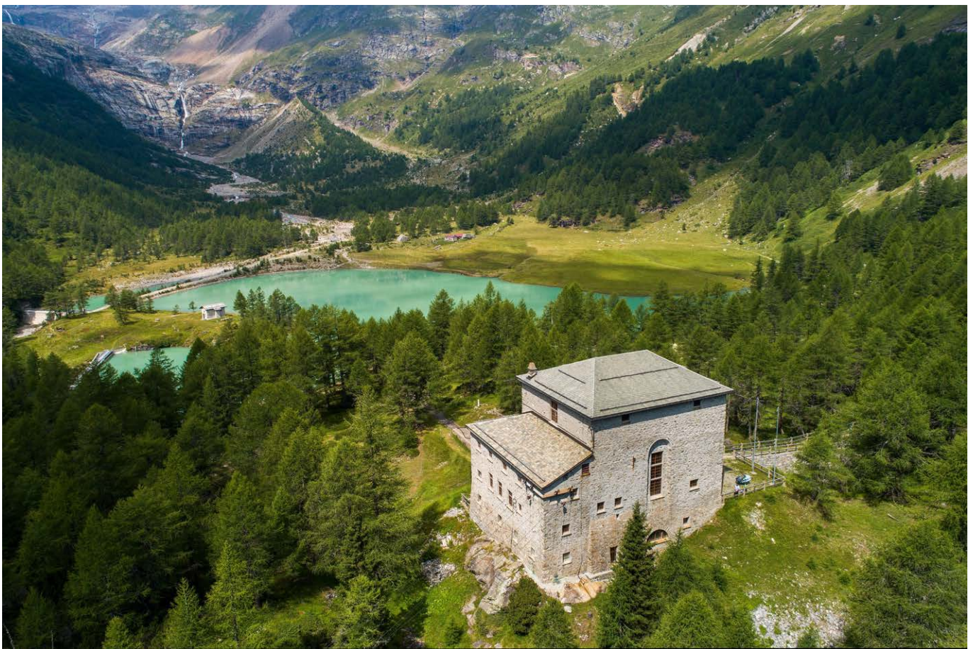
Palù power plant, Valposchiavo
