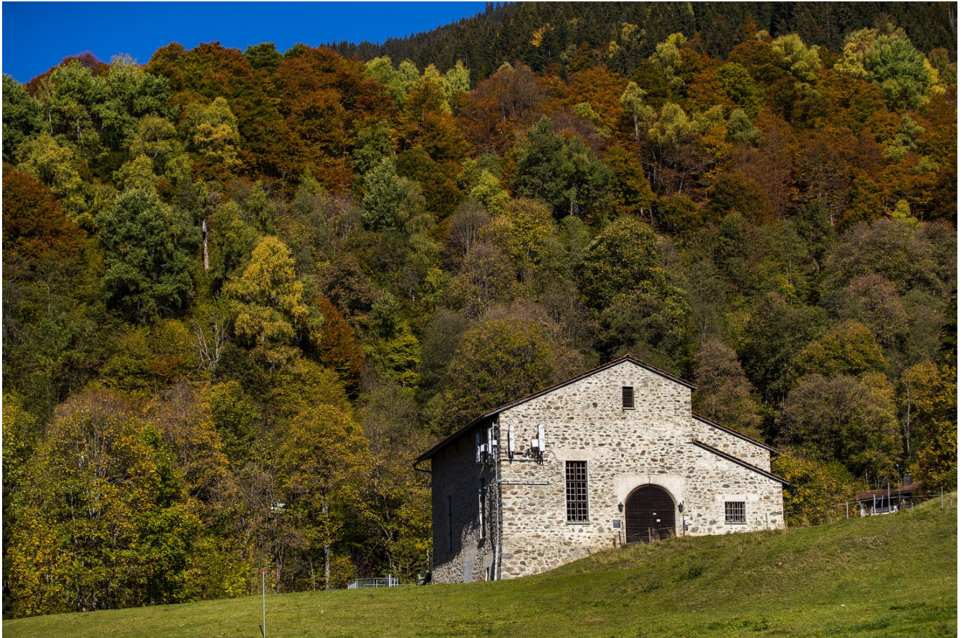
Kraftwerk Schlappin, Klosters
